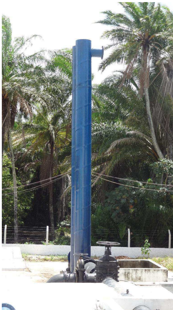
Figura 24 – Torre Piezométrica
