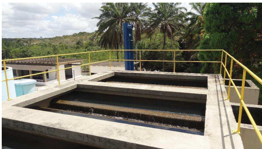
Figura 27 – Filtros Russos em Alvenaria.
