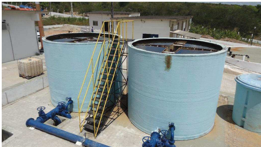
Figura 28 – Filtros Russos em fibra de vidro.
